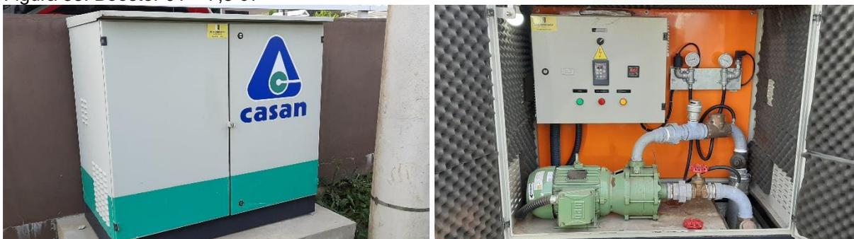
O Booster 02, também instalado no ano de 2020, opera atualmente cerca de 18 h/ dia, conforme programador de horário (*timer*). Esta unidade de recalque possui dois conjuntos motobomba de 2 cv, com partida indireta através de inversor de frequência. O painel de comando já possui componentes para telemetria, no entanto as informações da unidade ainda não podem ser visualizadas no sistema supervisorio da operadora.
