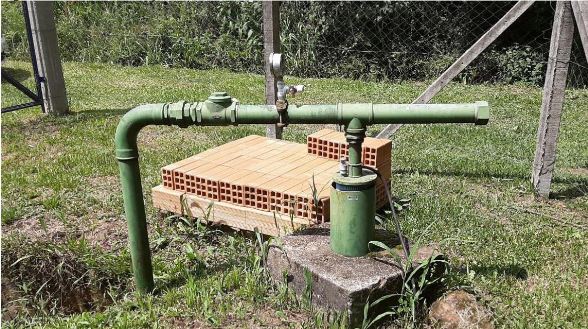
No cavalete do poço há um manômetro para controle da pressão, já o controle do volume captado no P04 se dá através de macromedidor do tipo Woltmann, com vazão nominal ( $Q_n$ ) de  $40 \text{ m}^3/\text{h}$ , instalado em tubulação após o cavalete (Figura 18).
