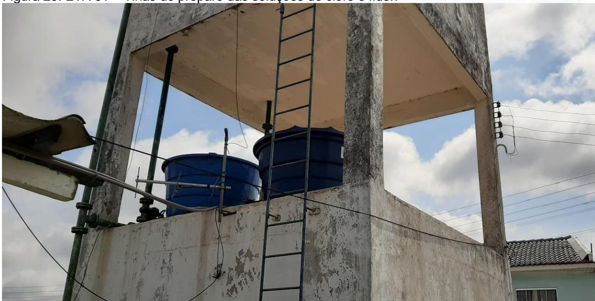
Figura 21: ETA 01 – Acesso as tinas por escada tipo marinheiro sem gaiola de proteção.
