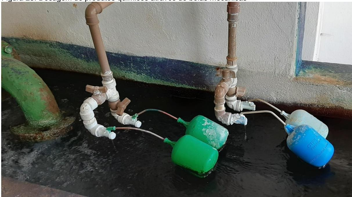
Os produtos químicos ficam armazenados dentro da Casa Química 1, não existindo estrutura de contenção para prevenir o risco de contaminação do solo em casa de vazamento dos produtos.
