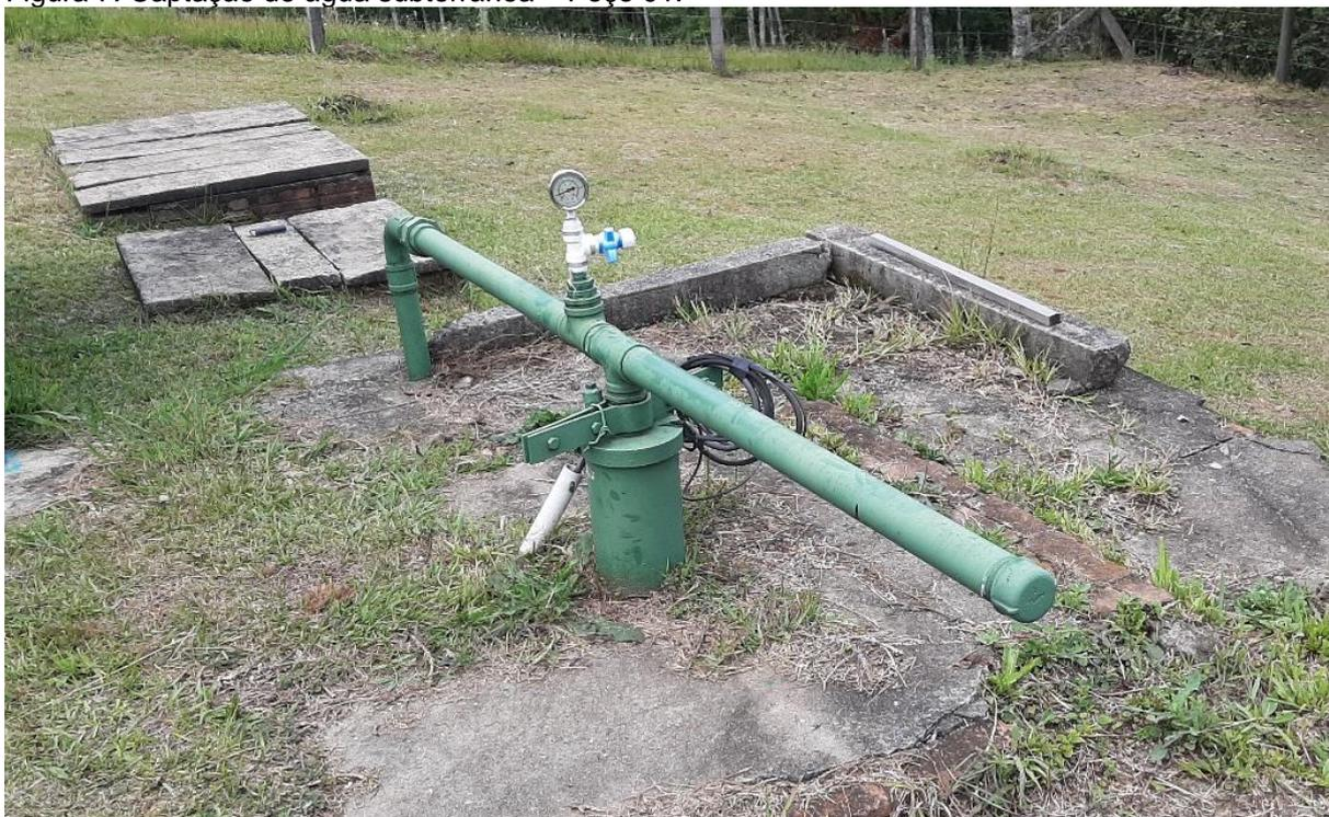
Na saída do P01 está instalado um macromedidor do tipo Woltmann para controle do volume captado (Figura 8).
