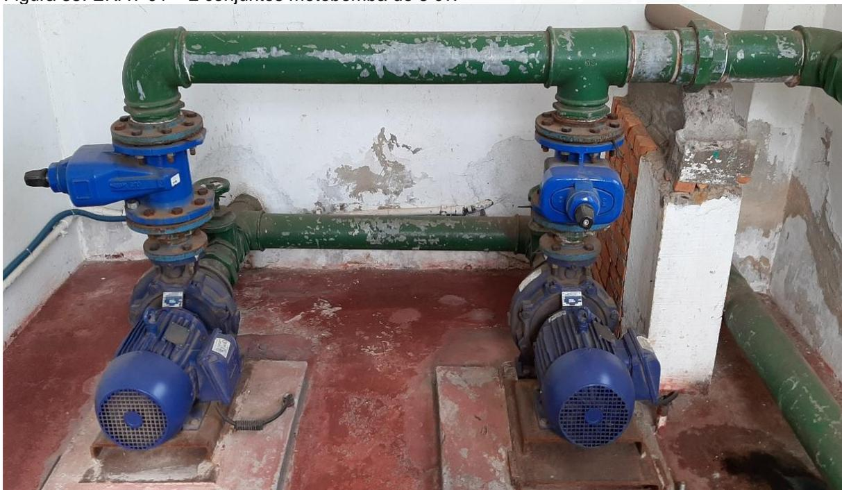
Figura 36: ERAT 02 – 1 conjunto motobomba de 12,5 cv e 1 conjunto motobomba de 10 cv.
