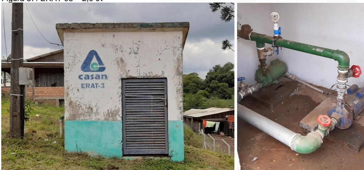
O Booster 01, instalado na Rua Rosalino Rodrigues – bairro Centro, no início de 2020, opera conforme programador de horário (*timer*), por cerca de 18 h/dia. Esta unidade de recalque possui um conjunto motobomba de 7,5 cv, com partida indireta
