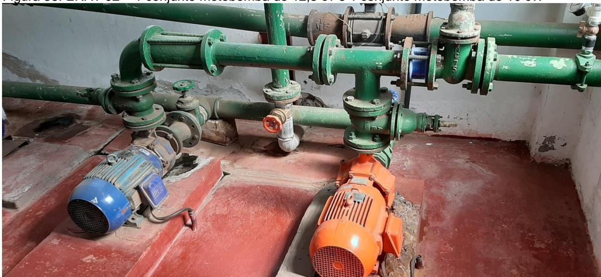
A ERAT 03, instalada na Rua Bom Jesus - bairro COHAB, é utilizada para recalcar a água da rede até o reservatório R3. A operação da ERAT se dá conforme o nível do R3, controlado por boia elétrica, funcionando por cerca de 12 horas/dia, por partida direta. Esta unidade de recalque possui dois conjuntos motobomba de 2 cv, no entanto, no dia da visita apenas um dos conjuntos estava instalado. A estrutura civil necessita de conserto de rachaduras e nova pintura.
