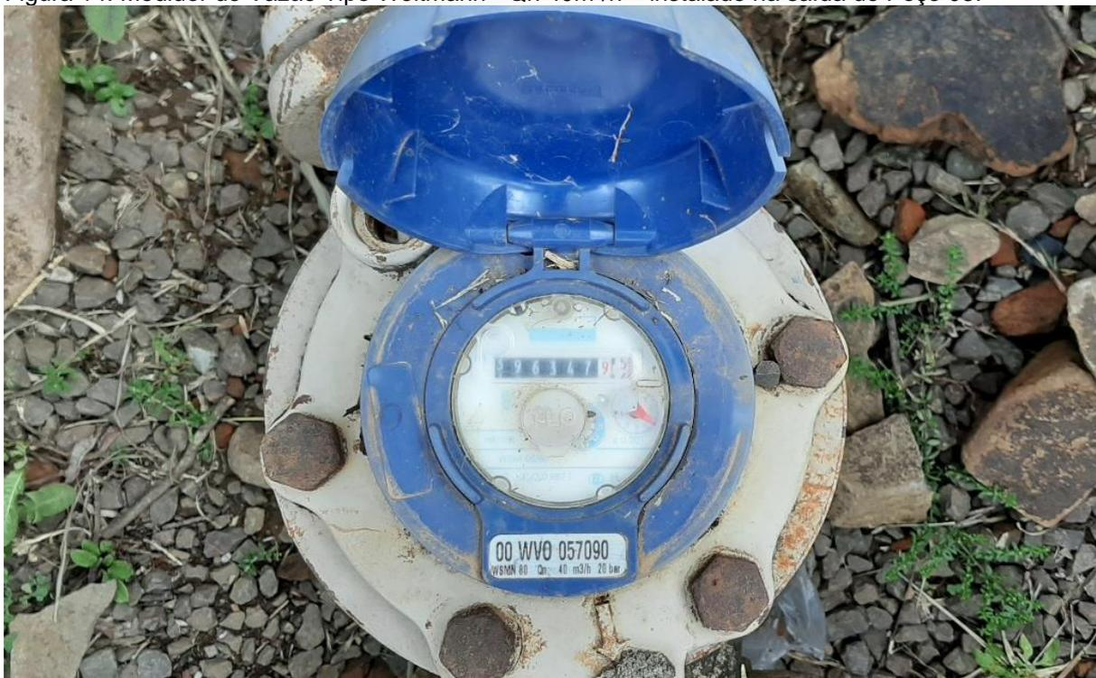
Figura 15: Tubulação de saída com manômetro e macromedidor – P03.
